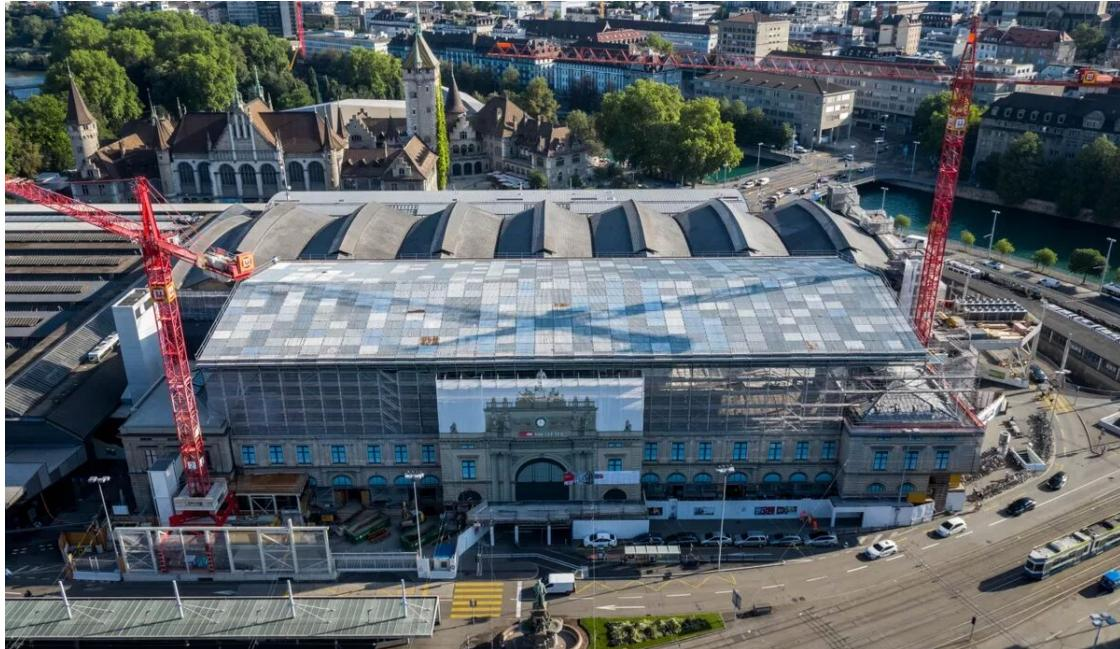
**La rénovation de l'aile sud de la gare centrale de Zurich représentait un défi : préserver la substance historique du bâtiment tout en le mettant aux normes les plus récentes en matière de physique du bâtiment, d'énergie et d'acoustique.**
