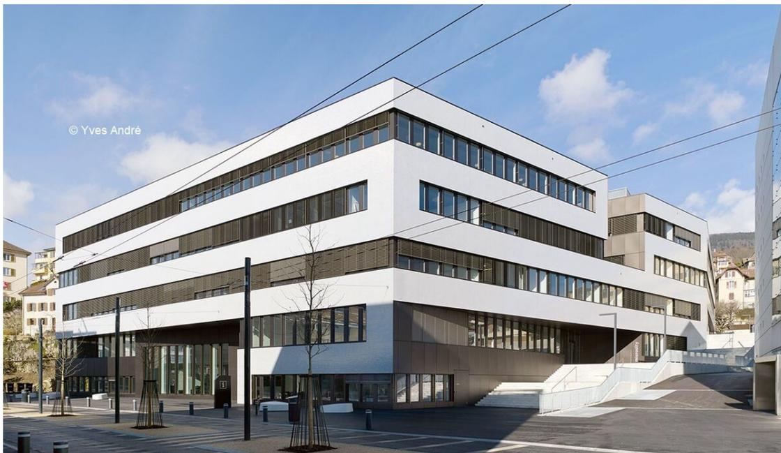
**Le nouvel immeuble de bureaux et laboratoires Microcity à Neuchâtel constitue un exemple intéressant de mise en œuvre des principes de la construction durable. Le bâtiment intègre de nombreux principes, au-delà des exigences du standard MINERGIE-ECO®, par exemple par l'utilisation du bois dans la structure ou par la création de surfaces vertes et de liaisons piétonnes dans un quartier difficilement accessible auparavant.**
