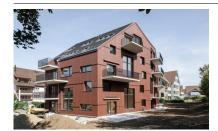
Dans le cadre de la nouvelle construction de l'immeuble résidentiel à Dällikon, 12 appartements en copropriété ont été créés. L'objectif était de construire un bâtiment de haute qualité énergétique, respectueux de l'environnement. Au niveau de la technique du bâtiment, une installation photovoltaïque et une pompe à chaleur à sondes géothermiques ainsi qu'une aération contrôlée étaient inscrites au programme. Le bâtiment a été certifié selon la norme Minergie.
